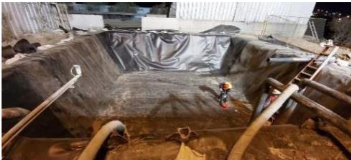
Imagen N°1: Piscina Agua de Proceso terminada de revestir
